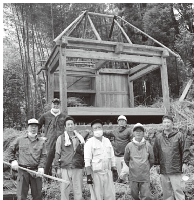
町組による茶堂の解体作業
