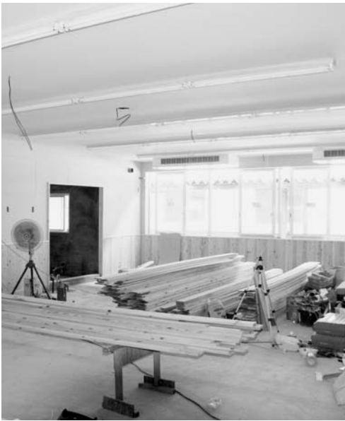
改修中の橋の木寮(給食室)
