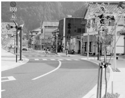
まち交大賞プロセス賞となったR440町中工区
