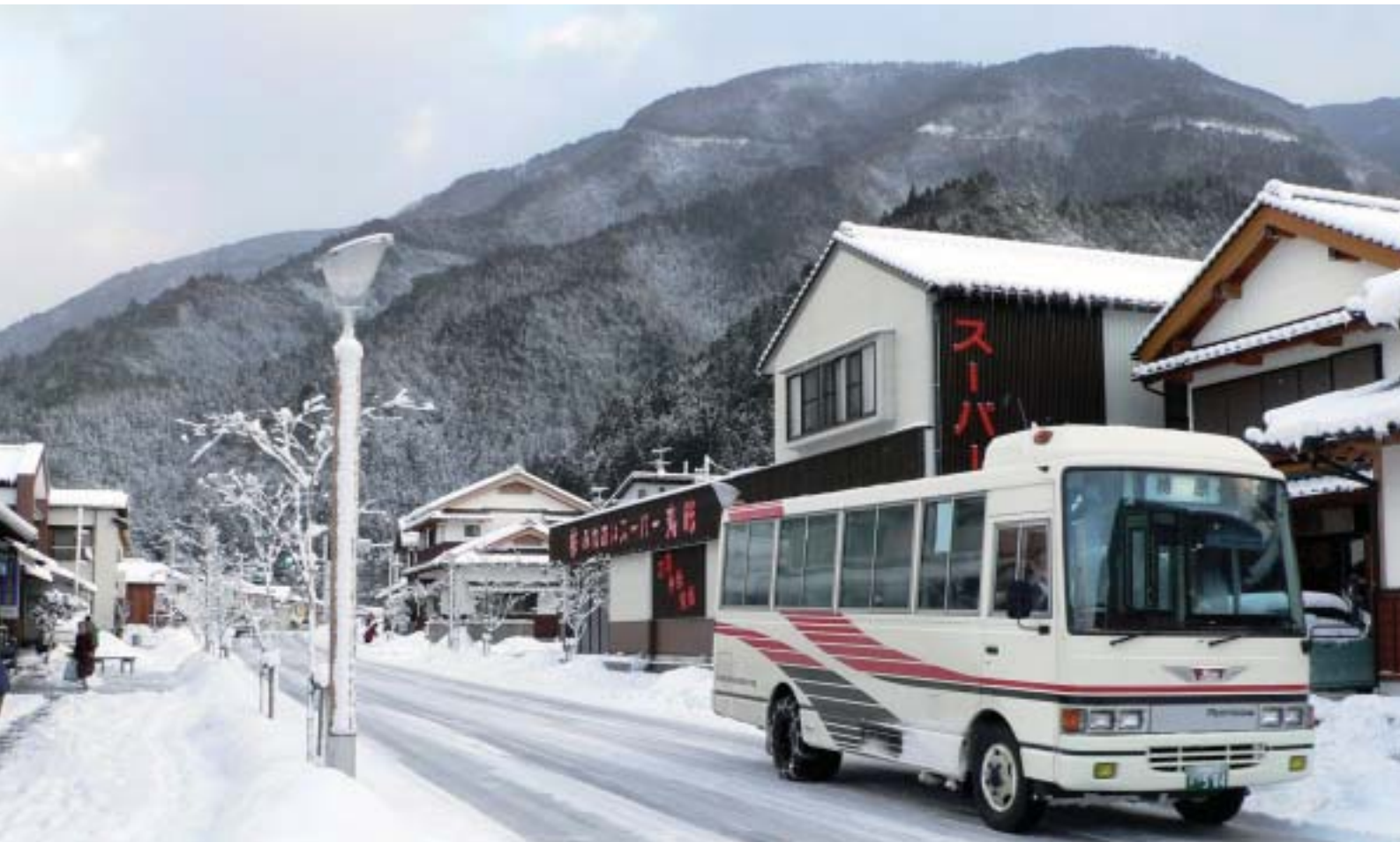
積雪の国道440号町中工区
