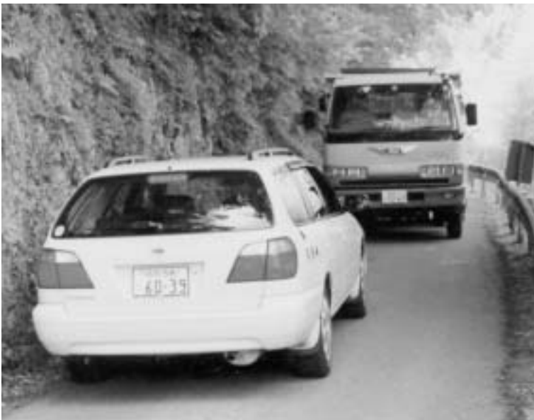
対向車と行き違いができない県道中平橋原線
