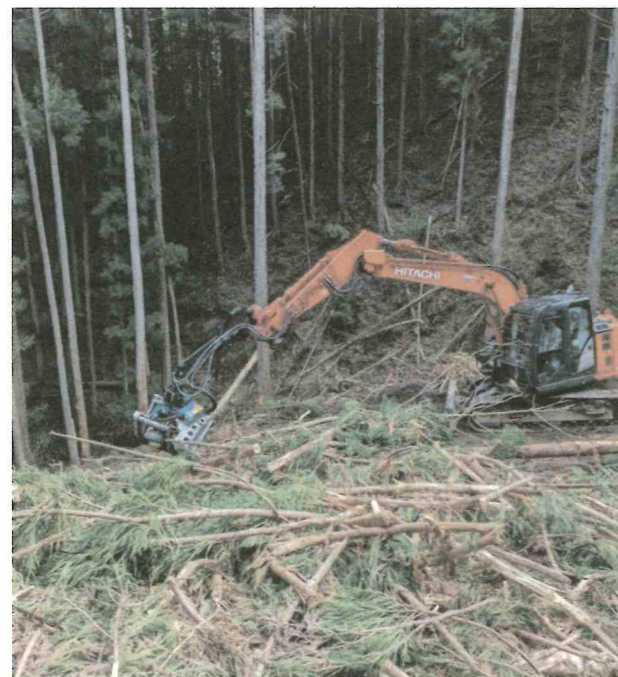
梶原運送の現場作業の様子
