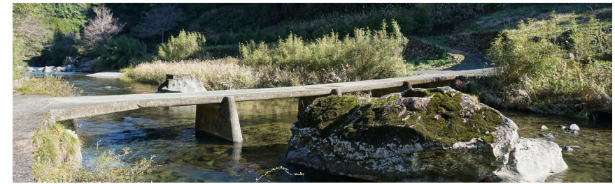
集落や農地への渡河を支える沈下橋 増水時には沈むことで損傷を防ぐ 川とともに生きる文化を伝える象徴的な要素である（川口）
