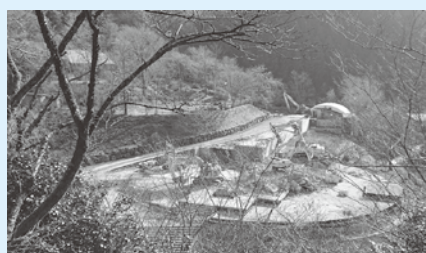
取り壊し工事中の雲の上のホテル及びレストラン
