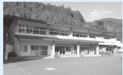
空調設備を導入予定の越知面遊友館
