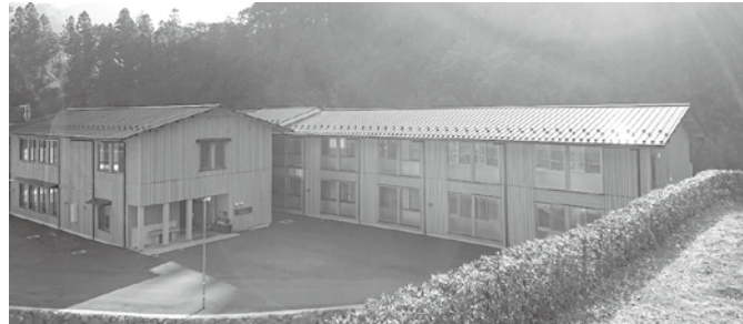
太陽光発電システム設置を検討していた生涯学習センター
