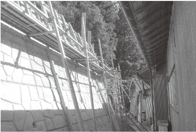
危険な住家の裏でがけくずれ対策工事を行う様子
