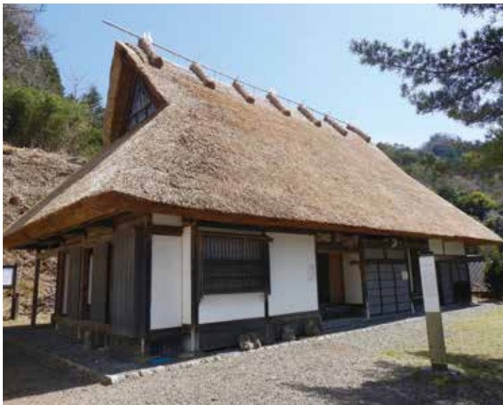
改修後の旧掛橋和泉邸
