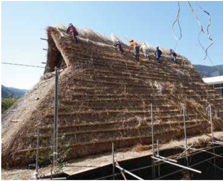
改修中の旧掛橋和泉邸
