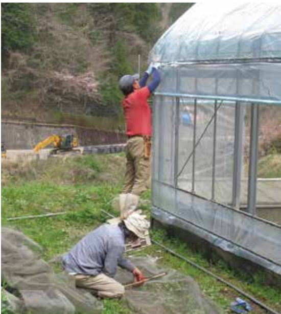
ビニール張り替え作業
