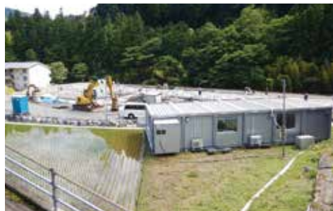
建設場所:大蔵谷 (以前J A津野山が苗床として使用していた町有地)
