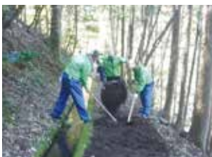
セラピーロード修繕作業
