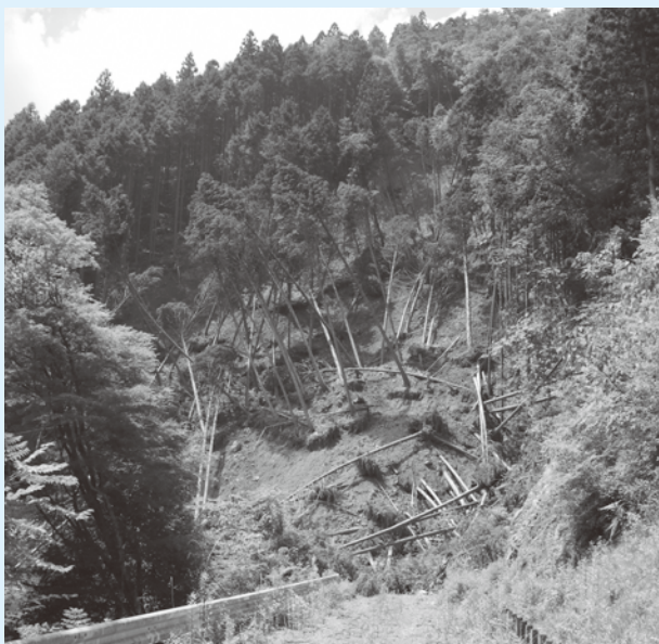
林道西の川川井線災害現場
