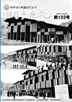
落成を迎えた、「雲の上の図書館」 「複合福祉施設 YURURIゆすはら」
