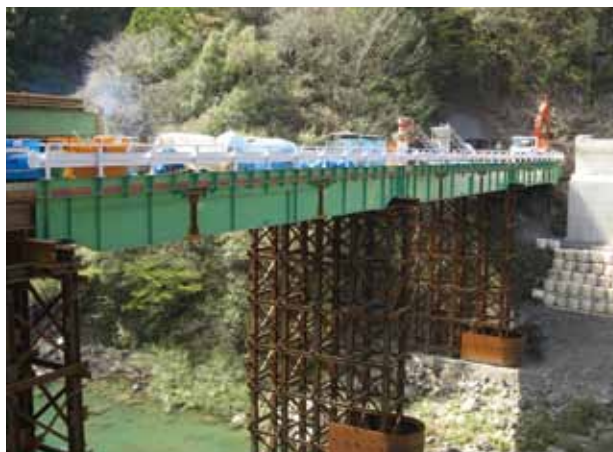
写真：待ち望まれる改良工事（鷹取地区）
