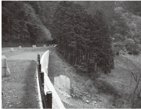
佐渡地区の改良工事
