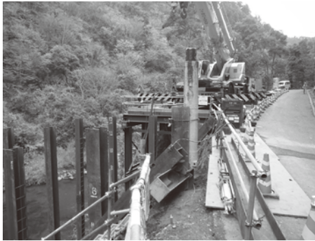
鷹取地区の改良工事
