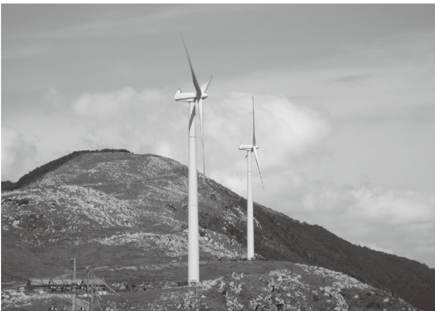
しっかりとした修繕計画の中、良好に管理されている現在の風力発電所
