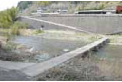
37 仲間橋（沈下橋）
