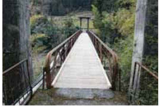
43 初瀬橋（吊り橋）
