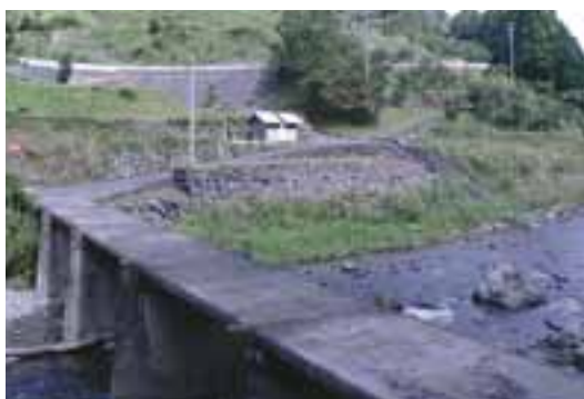
34 中小屋沈下橋
