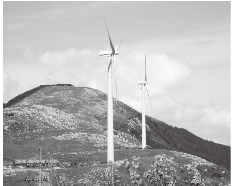
現在の梶原町風力発電所 600kW×2基
