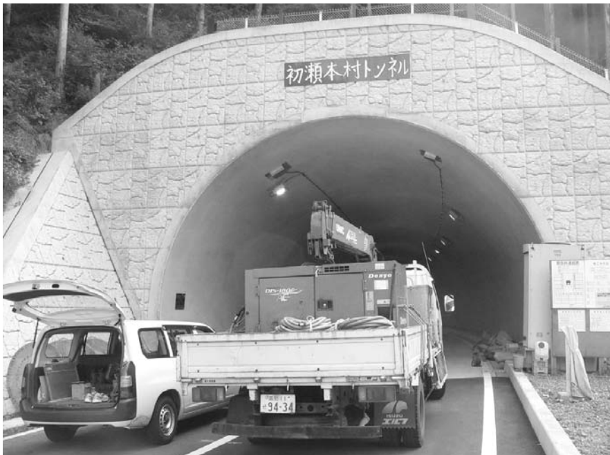
開通間近の初瀬本村トンネル
