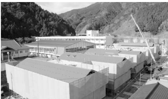
建設が進む小中一貫校
